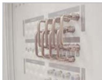
As ligações dos circuitos de TV são efectuadas no interior da caixa sendo a comutação por troca de pontes.
