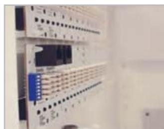
Fornecidas com botão de teste que permite certificar a Categoria 6. Ligações efectuadas no interior da caixa através da fixação dos pares com o alicate de Krone.
